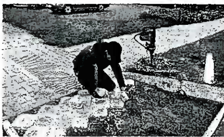
В АРСКЕ ПРОКЛАДЫВАЮТ СПЕЦИАЛЬНЫЕ ПЛИТКИ ДЛЯ СЛЕПЫХ. Фото автора
